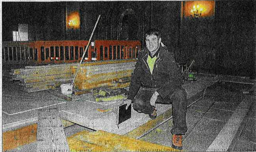
Andreas Graßl, Bauunternehmer aus Ramsau, zeigt, wie ein neuer Holzsteg aus verschiedenen Schichten auf den alten Boden gelegt wird.
